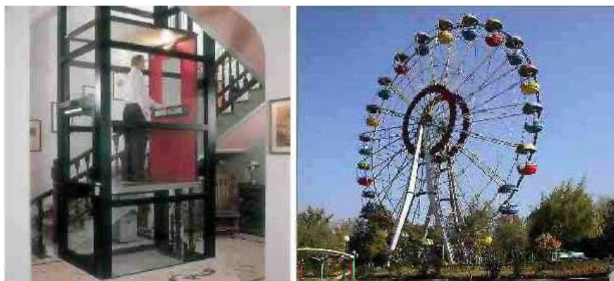
Рис. 1.11 Прямолинейное поступательное механическое движение кабины лифта и криволинейное поступательное движение кабины колеса обозрения [Источники заимствований: URL: http://lift-m.ru/index2.php?option=com_content&task=view&id=44&pop=1&page=0&Itemid=57 ; (с изменениями); http://www.fergananews.com/article.php?id=5205 ]
