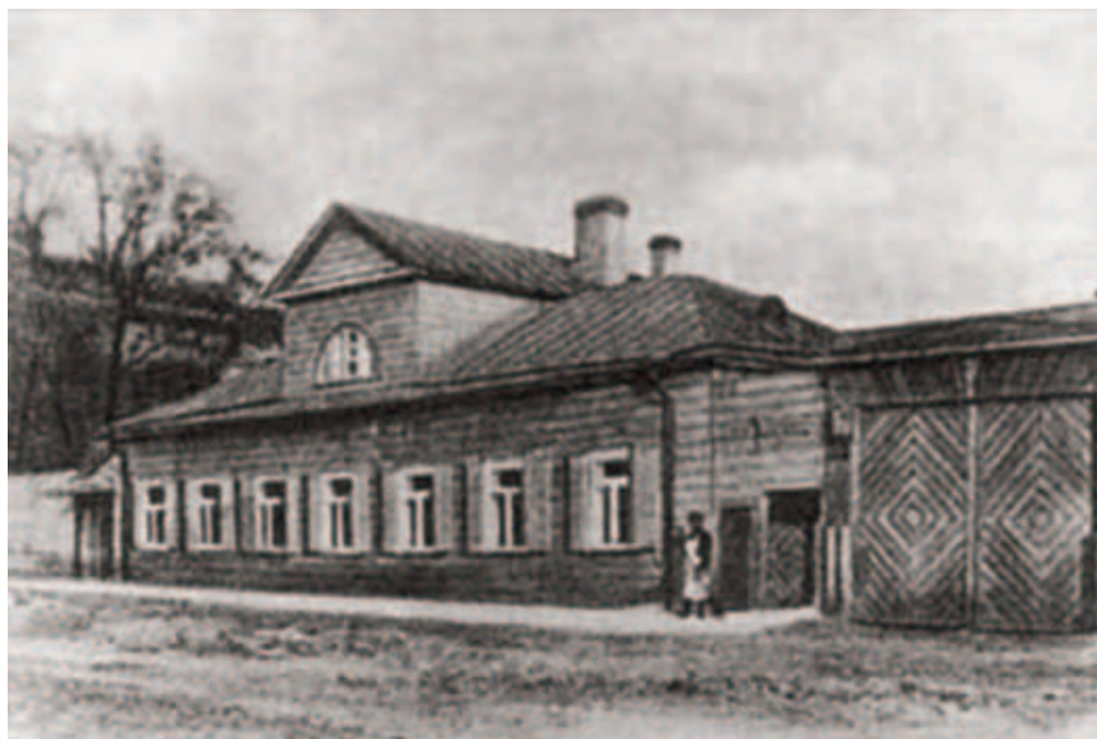
Дом семьи Нобелей в Петербурге, Петербургская набережная, 24. 40-е годы XIX в.
